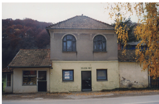
Sl. 46: Kuća na kbr. 22
