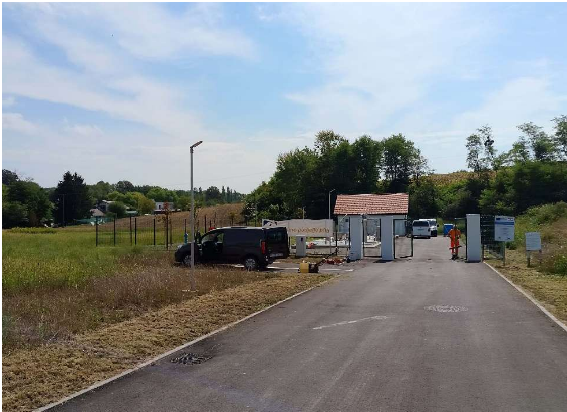
Slika 5: Uređaj pročišćavanja otpadnih voda Štrigova
